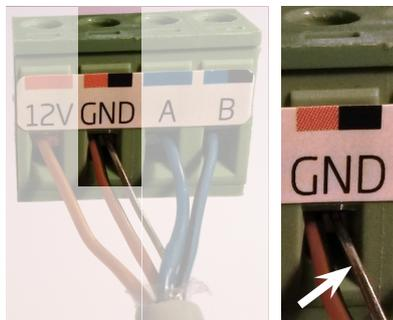
Skærm til både betjeningspanelet og alle sensorer termineres ved styreboksen inde i ventilationsanlægget efter følgende anvisninger.
